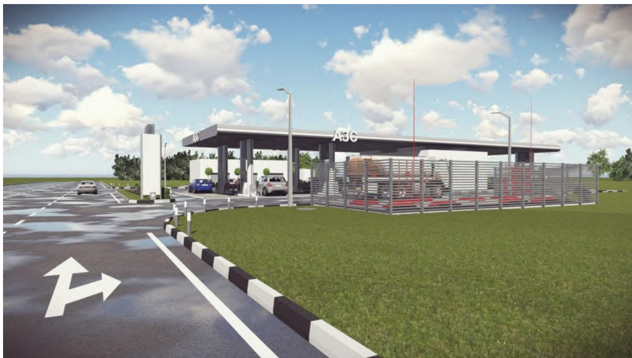
Ограждение мусорных контейнеров и контейнеров хранения топлива
