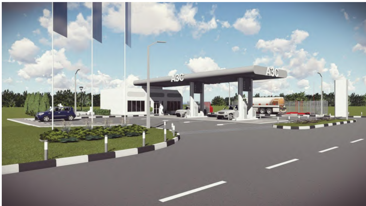
Подсветка островка и зоны въезда\выезда на АЗС
