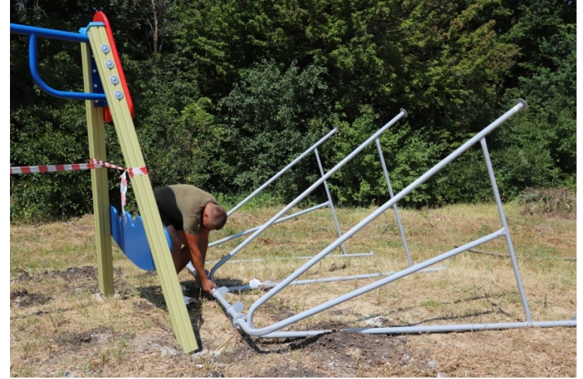
В процессе работ
