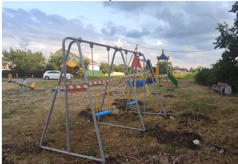
В процессе работ
